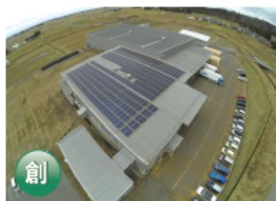
工場の屋根に太陽光パネルを設置。発電した電力は工場内で自家消費。
